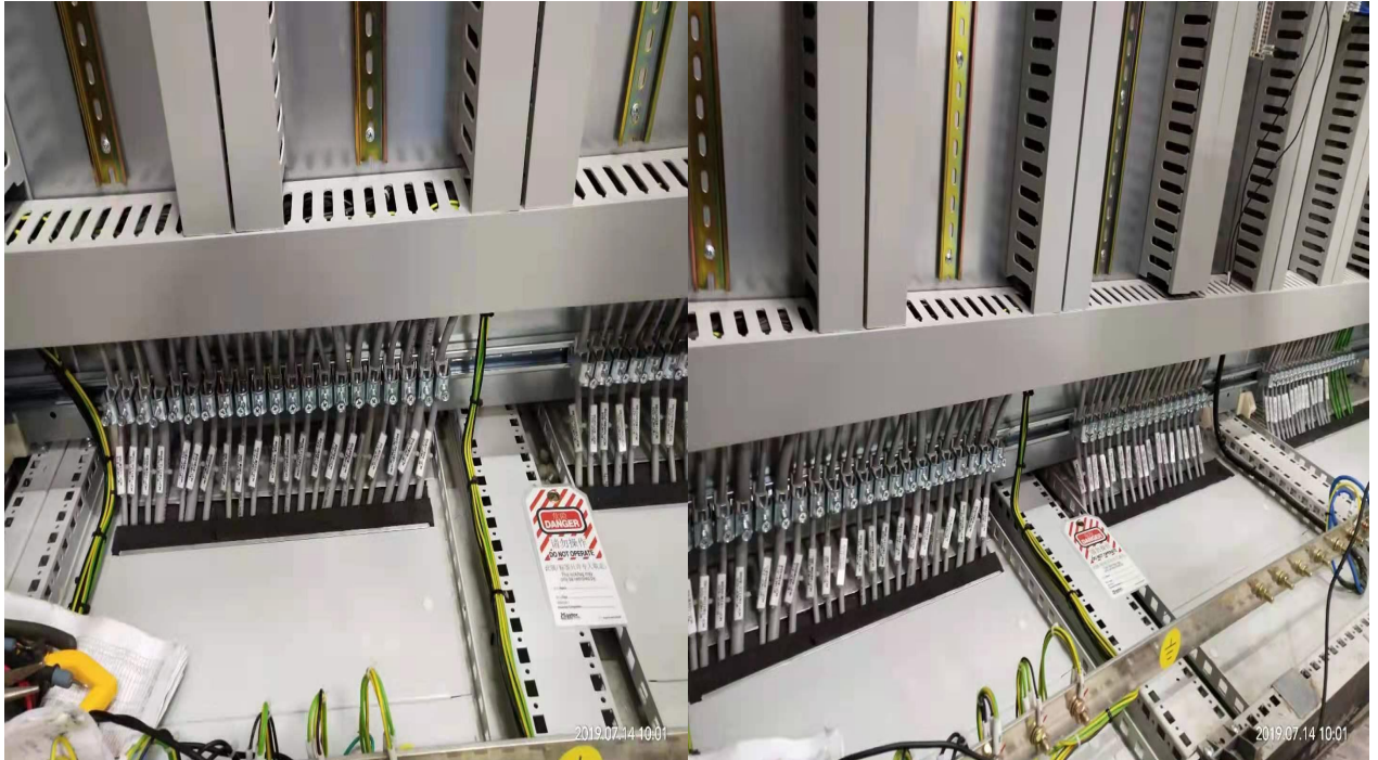
示例安装图片二：桥架电缆固定及不同电压等级电缆分层
